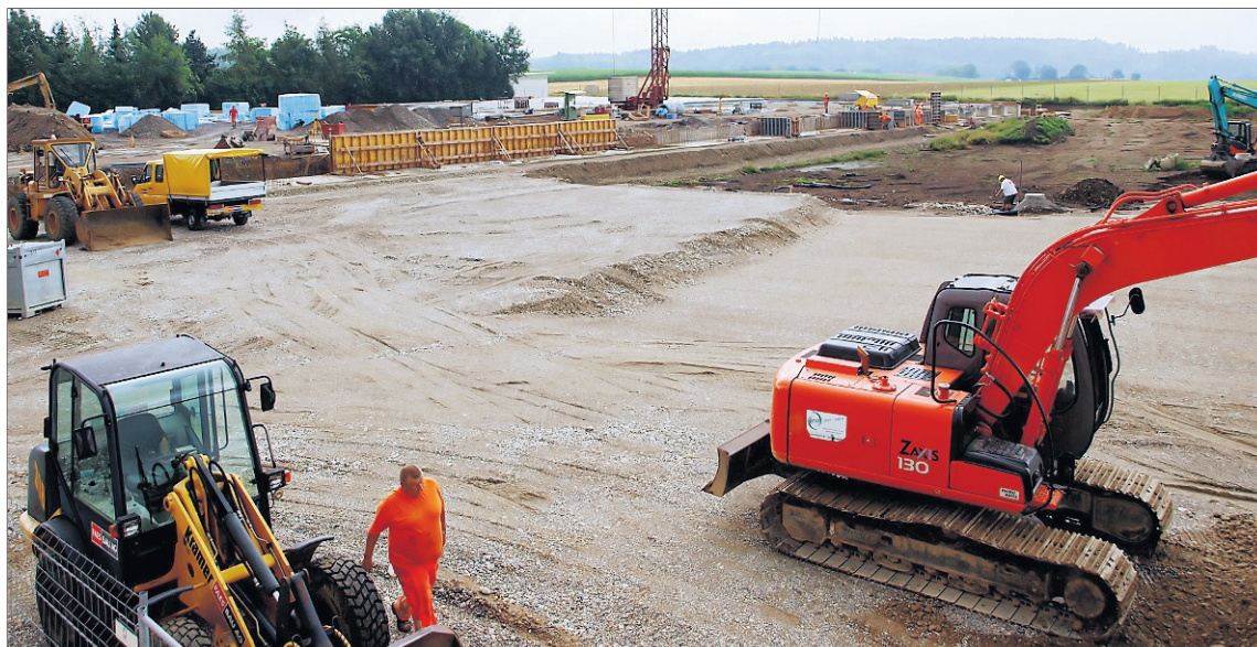
IM ZEITPLAN Auf der Baustelle vom Volg-Verteilzentrum läuft bisher alles rund. COM
